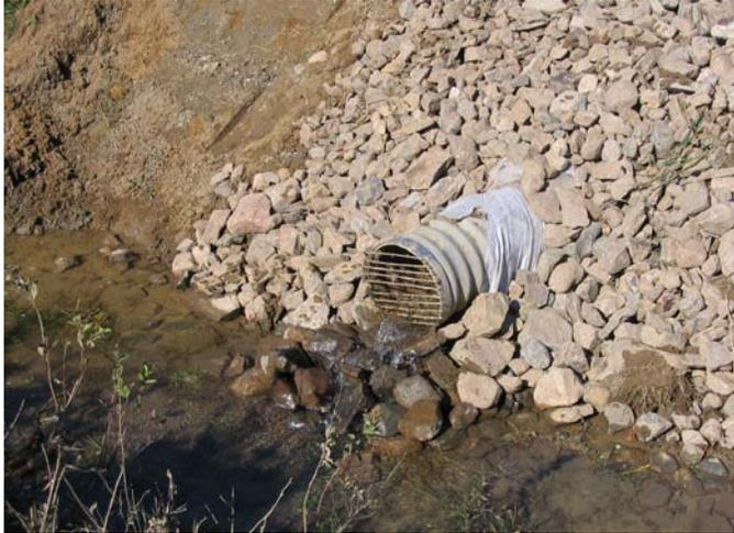
Photo 1 : Sortie de drain avec grille amovible
